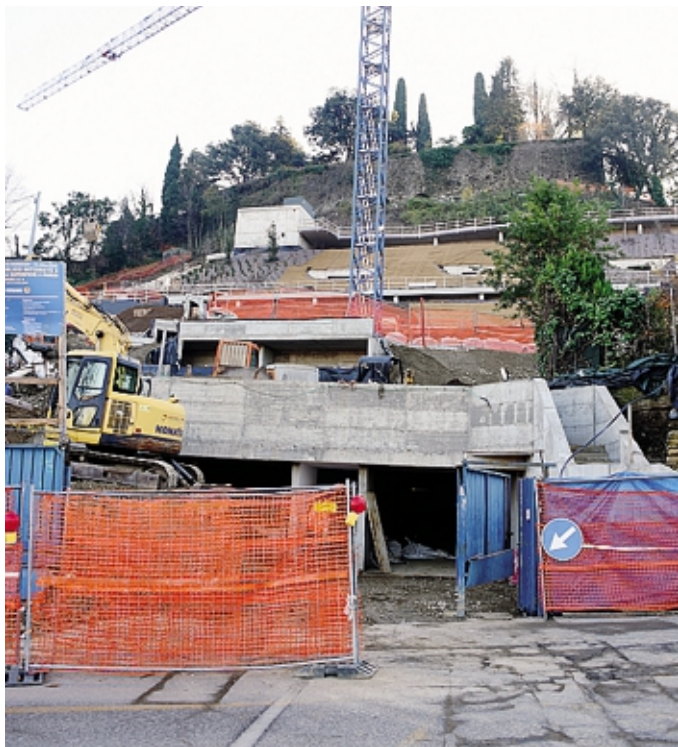
Il cantiere: è in corso il «riempimento» della parte superiore BEDOLIS
