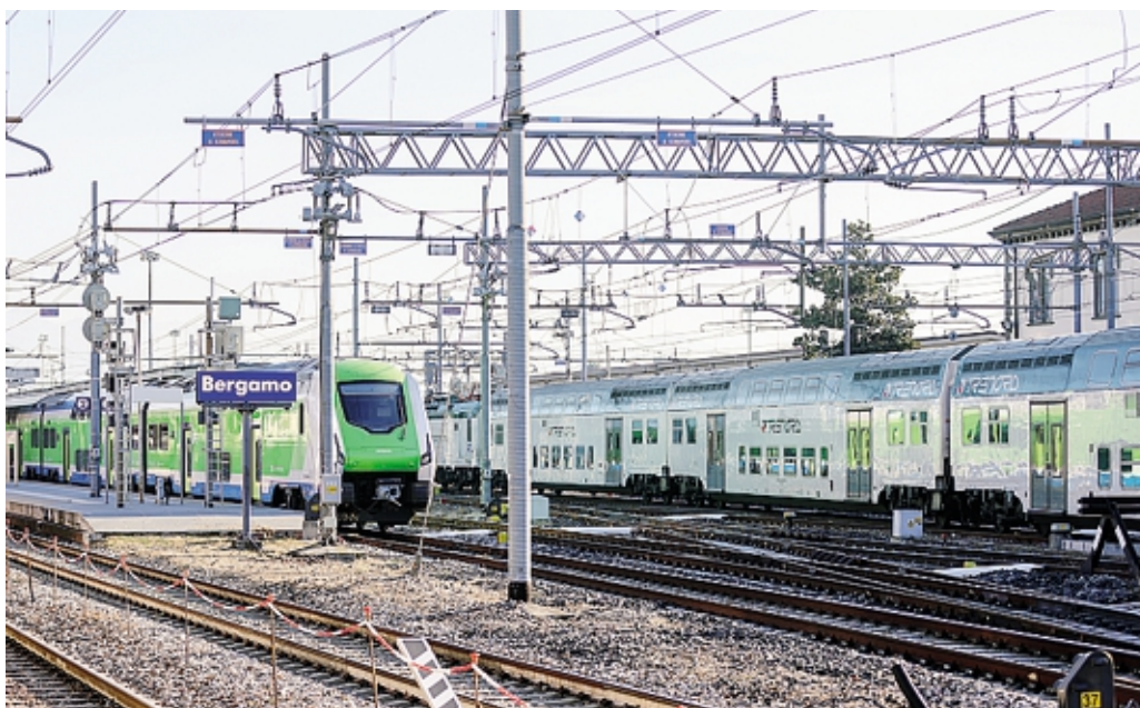
Sono partiti i lavori alla stazione ferroviaria di Bergamo
