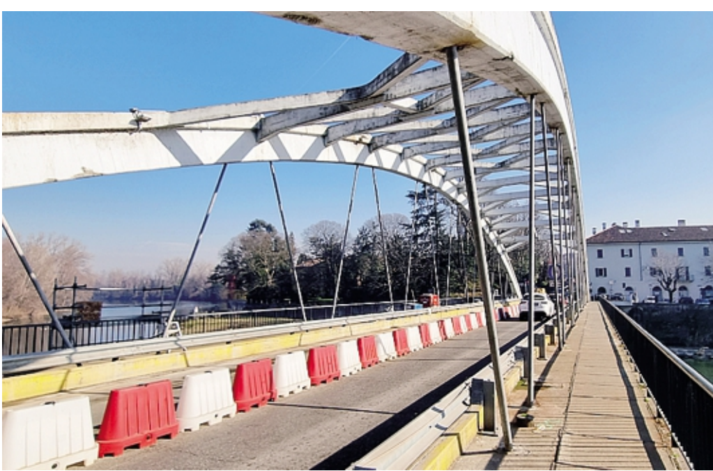
Il ponte di Canonica, i lavori di ristrutturazione sono ormai conclusi
