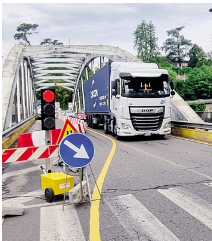
Camion in transito prima del divieto scattato con i lavori
