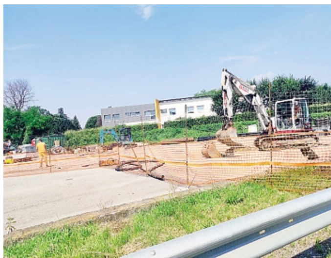
Operai al lavoro in via Rovelli sul cantiere per il sottopasso
