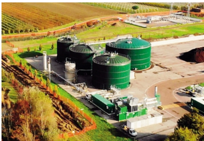
Un impianto di biogas in campagna
