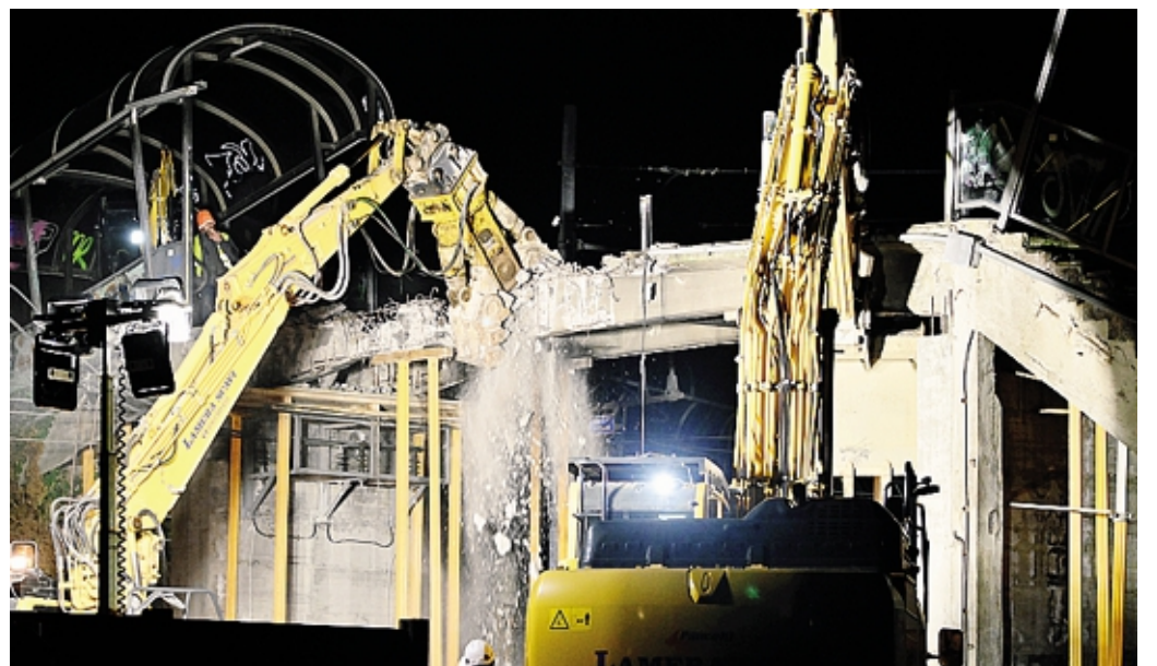
Le pinze demolitrici in azione dalla notte fra sabato e ieri per frantumare la passerella FOTO BEDOLIS
