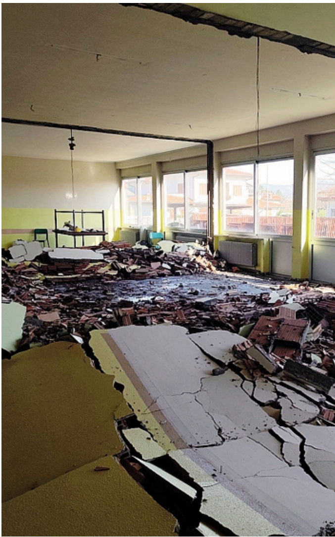
Le opere di demolizione in atto all'interno delle scuole medie
