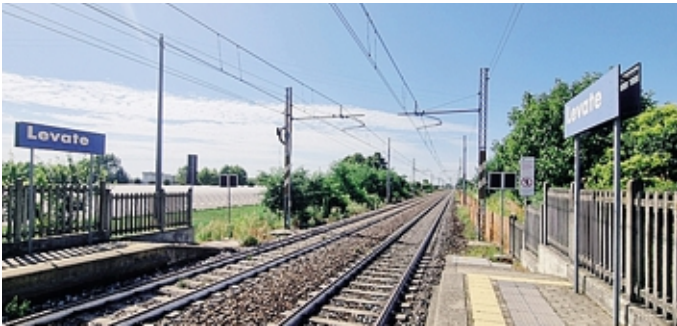
La fermata ferroviaria di Levate
