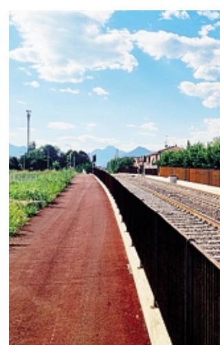
Un tratto di pista ciclabile BEDOLIS
