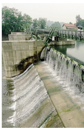
Diga per centrale idroelettrica
